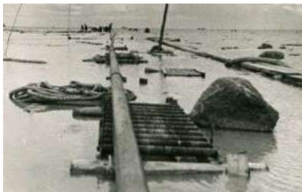
Рис. 3. Укладка подводной части трубопровода в блокадный Ленинград на вращающиеся валки [19].
